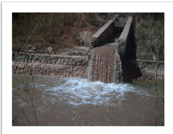
Le déversement des effluents de l'usine de Lulu à KZI
