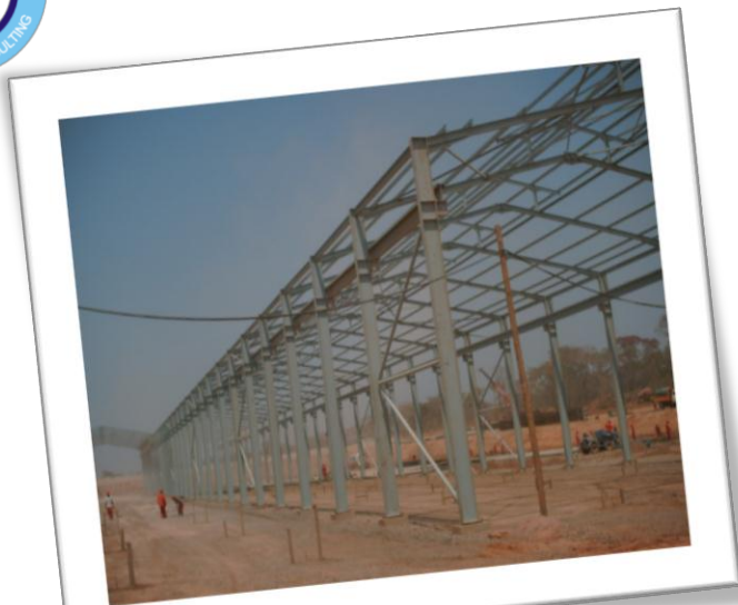
Le début de la Construction du complexe D'électrolyse (EW)
